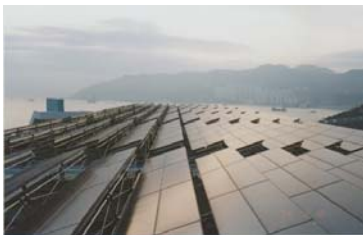
綜合式建築物太陽能發電上網系統(BIPV)。
